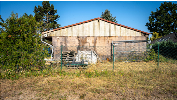
Straßenansicht mit Abrissobjekt
