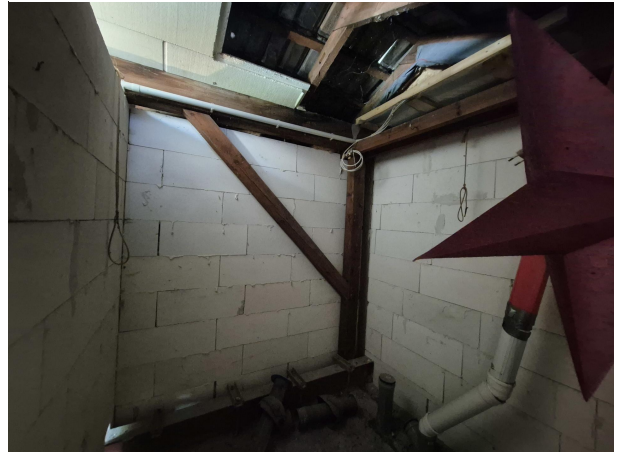
Raum für ein mögliches WC im DG
